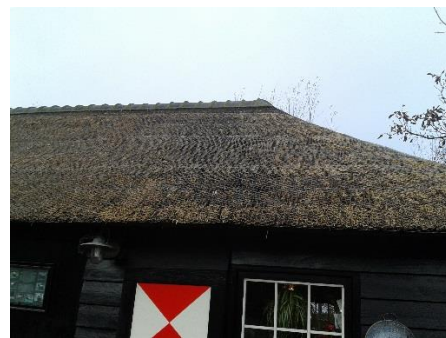
Kap na de reparatie
